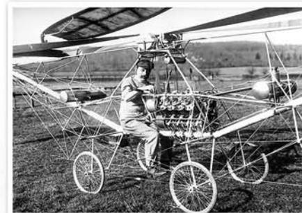
El ingeniero francés Paul Cornu lleva a cabo el primer vuelo en helicóptero de la historia. Con un motor de 24 CV y dos rotores de rotación inversa ubicados a ambos lados del aparato, consiguió elevarse unos 30 cm del suelo durante 20 s.
